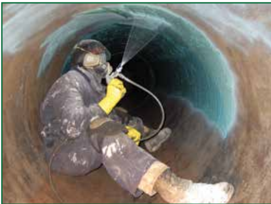
Aplicación de epóxico de alta construcción de película Novocoat SG2500 Lining .
