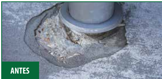
Novolite Repair Mortar usado en concreto.
